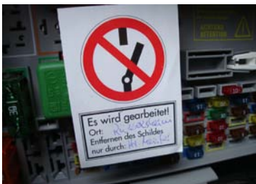
Bild 2: Kennzeichnung „Gegen Wiedereinschalten sichern“
