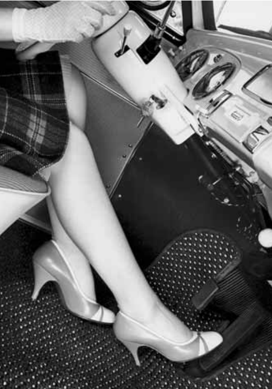
Der „Saxomat“, erste automatische Kupplung für Personenwagen
